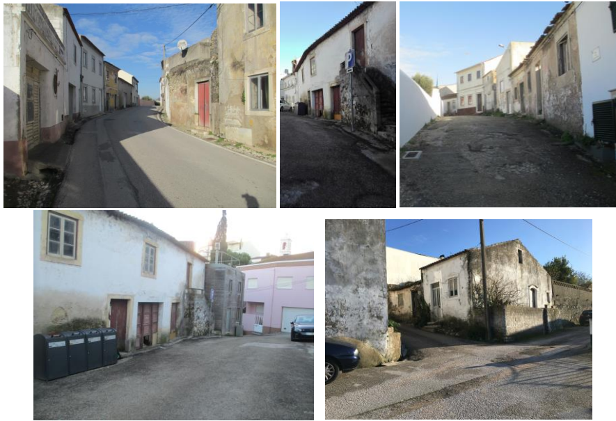
Figura 32. Parque edificado da ARU da Vila de Montemor-o-Velho
