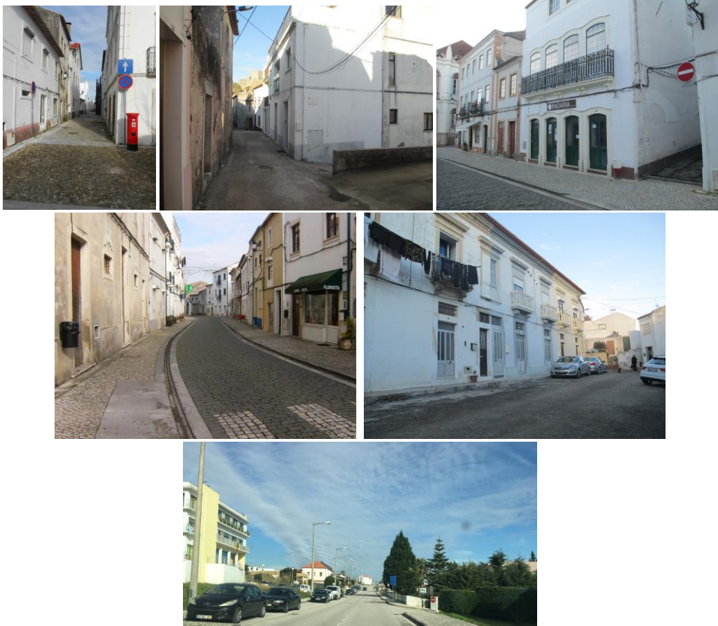
Figura 27. Parque edificado da ARU da Vila de Montemor-o-Velho
