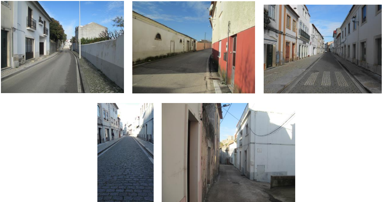
Figura 45. Exemplos de tipos de pavimento da rede viária da ARU da Vila de Montemor-o-Velho
